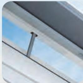
En la versión eléctrica, la ventana de cubierta horizontal se controla a través del mando a distancia con el sistema domótico inalámbrico Z-Wave. El motor en las ventanas de apertura eléctrica se coloca en la hoja, lo que limita la influencia perjudicial de las condiciones climáticas (lluvia, nieve). Esto garantiza un funcionamiento óptimo de todos los elementos de control y del motor, aumentando su fiabilidad.
